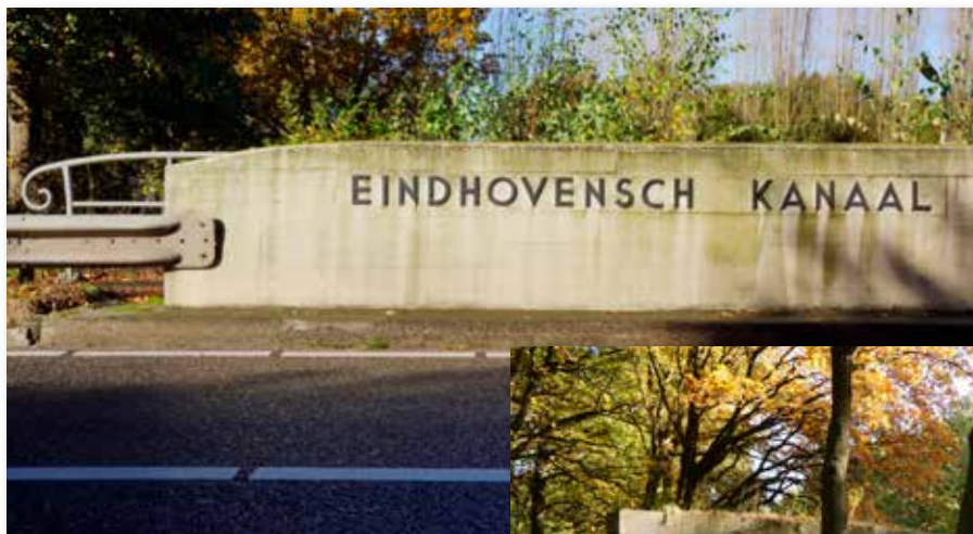
Oude spelling op de betonnen brug van de Geldropseweg (foto links).
