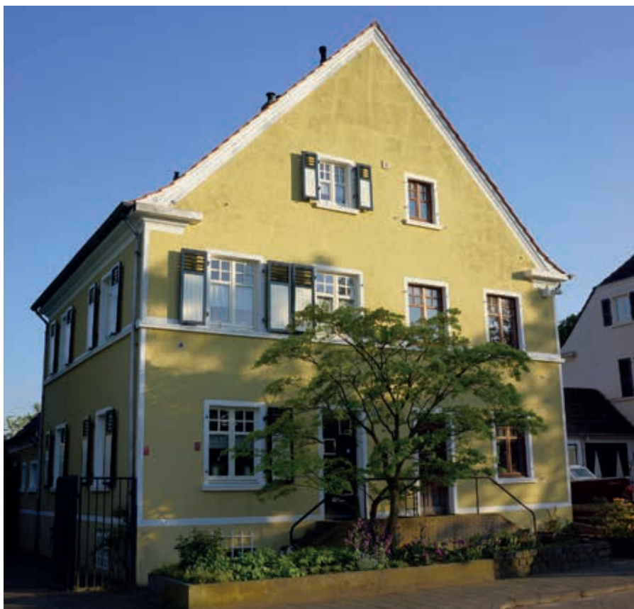
Het eerste blok Helmathuizen vanuit Helmond gezien heeft onlangs een frisse opknapbeurt gekregen.
