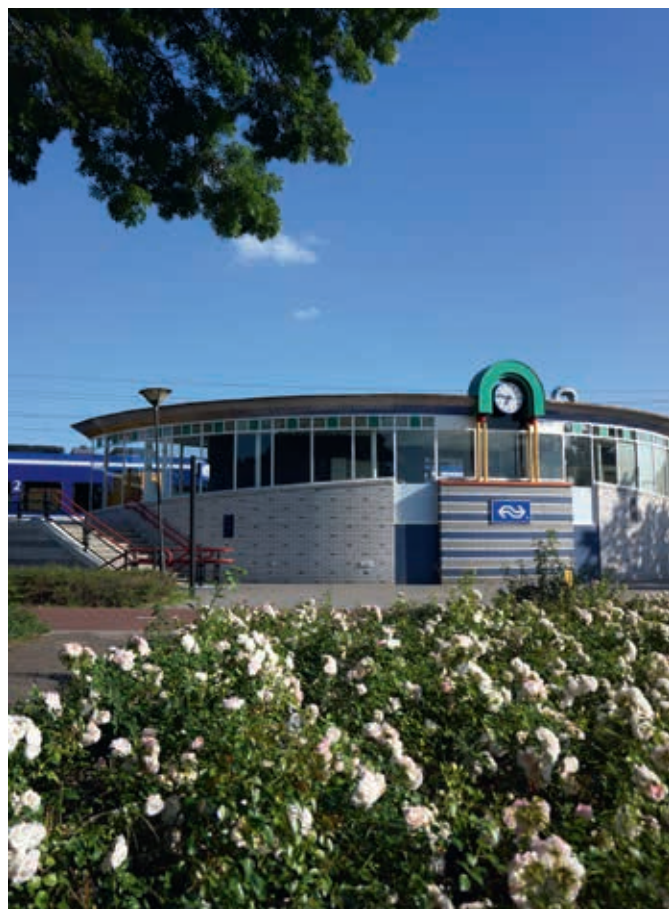
De gemeente Mierlo ijverde al in 1896 voor een eigen station in Mierlo-Hout. Uiteindelijk werd Station Helmond-t Hout in 1992 gerealiseerd als derde station van Helmond.
