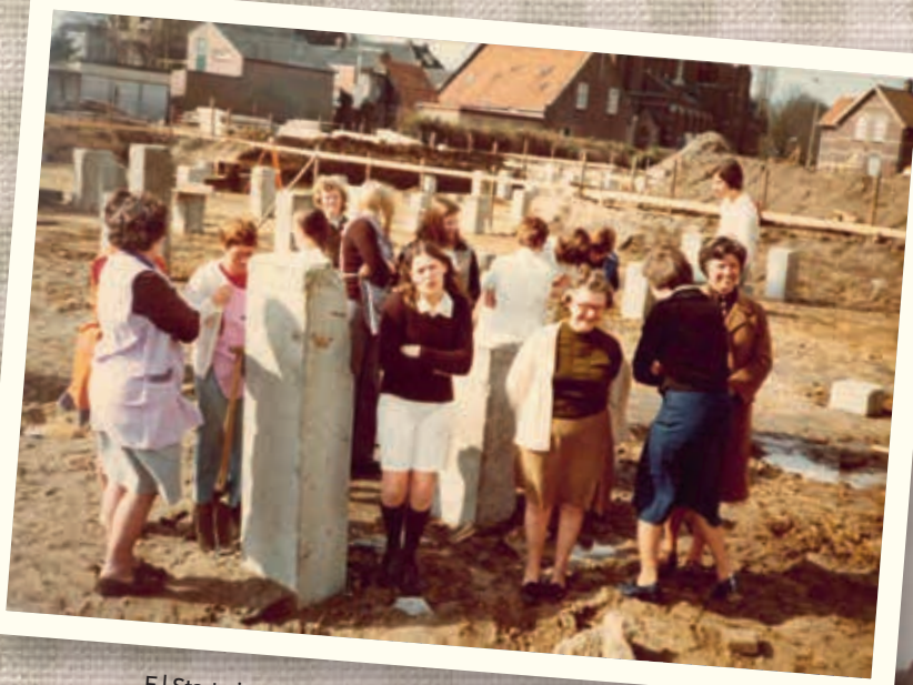
F | Start nieuwbouw, die inmiddels weer gedeeltelijk is gesloopt.
