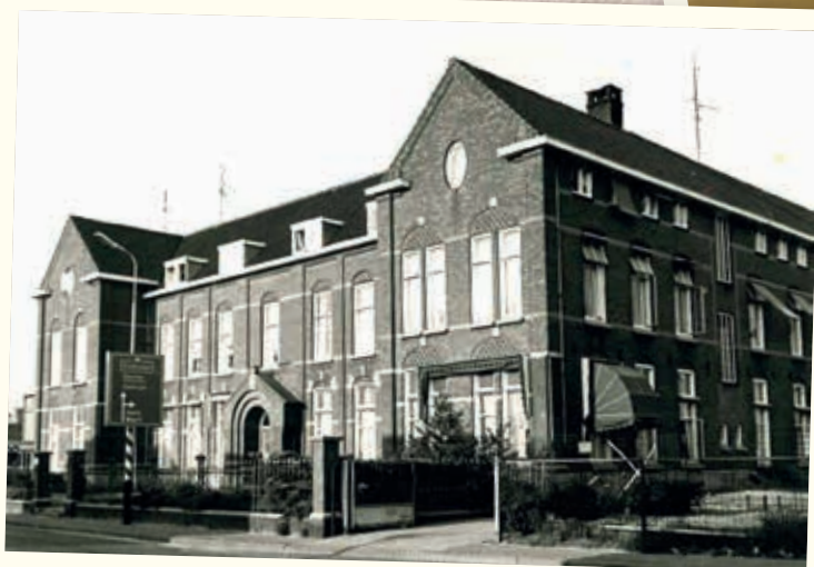
F | Het allereerste gebouw aan de Hoofdstraat, meisjesschool/kleuterschool St. Lucia.
